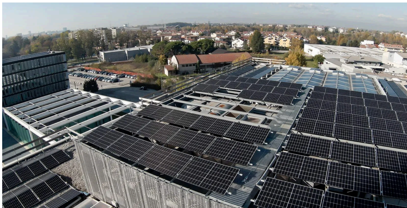
Foto impianto fotovoltaico realizzato da gruppo Itieffe
