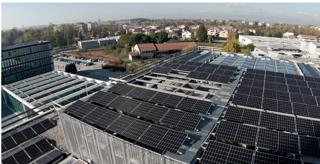
Foto impianto fotovoltaico realizzato da gruppo Itieffe
